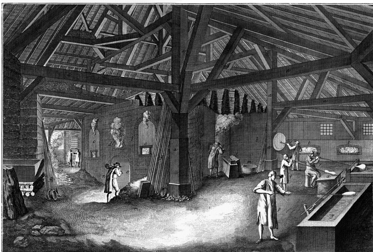
Verrerie en bois, Grande Verrerie en Plats. Intérieur d'une Halle et différentes Opérations de la Verrerie à Vîtres. Bonard del.
